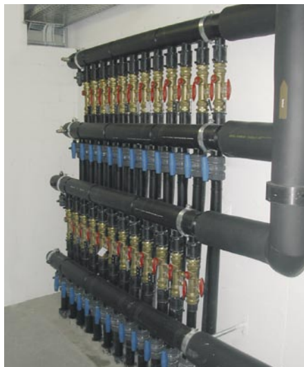
Beispiel für GEROtherm®-Verteiler und Sammler für die Erdwärmesonden. (Bild: KWT AG) GEROtherm®-Erdwärmesonden Ø 32 mm und Ø 40 mm. (Bild: Haka.Gerodur AG)
