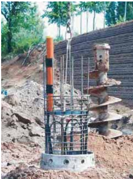
Abbildung 4.6: Bohrpfahl (Bild: enercret Röthis)
