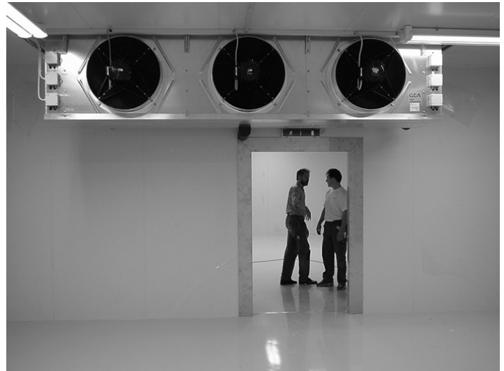
Verdampfer im Bau 189
